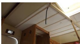
Auch der Bereich um den Schrank herum ist soweit fertig. Da der vordere Bereich des Innenraums schlecht ausgeleuchtet wurde, habe ich eine neue Lampe im vorderen Teil vorgesehen. Man sieht das eine Ende des Kabels aus der Decke hängen. Das andere Ende befindet sich im Schrank, da dort ein Lichtschalter installiert wird.
