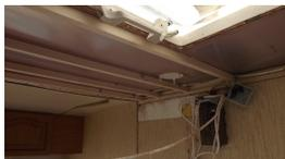
Die neue Kantenleiste im oberen Bereich ist eingeklebt und mit den bestehenden guten Holzteilen verschraubt. Einige Querlatten sind bereits für den Einbau vorbereitet.
