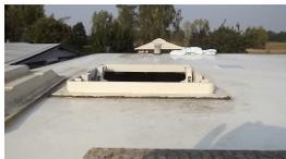
Wenn man die Decke und das Dachfenster erneuert, dann sollte das alte Dachfenster vor dem Einbau der neuen Decke komplett ausgebaut werden. Die Dichtung kann mit einem Cuttermesser aufgeschnitten und dann entfernt werden.
