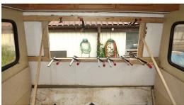
Die Holzteile welche den Rahmen des hinteren Fensters bilden wurden eingeklebt. Hier die Innenseite.
