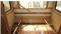
Die untere Verkleidung der hinteren Wandschräge ist eingeklebt. Zwischen ihr und dem Fenster habe ich eine zusätzliche Leiste quer über die Wand eingesetzt. Sie dient der Stabilität und dem anbringen der Winterrückenlehne.
