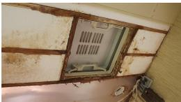
Die verfaulte Umgebung des Dachfensters. Um die Decke hier zu entfernen, muß man den unteren Rahmenteil des Fensters vorher abmontieren.
