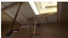
Jetzt sind alle Querlatten, das Styropor, der Rahmen um das Dachfenster und die Verstärkung für den Auslaß des Dunstabzugs, fertig. Hier stehen vorübergehend Stützen. Dieser alte Azur hat eine wesentlich bessere Wärme- und Schalldämmung als z.B. ein Südwind von 1997. Auch fehlt hier das typische Knistern und Knacken welches bei Temperaturschwankungen in neueren Modellen zu hören ist.
