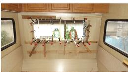
Die neue Verkleidungsplatte wird eingeklebt.
